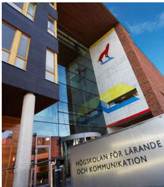
BOKEN ÄR ETT FÖNSTER Väggnestverk i betong och kakel av Åke Pallarp, Stockholm. Konstverket fortsätter in i entréhallen med en gul kakelvägg. Placerat år 2000 vid östra entrén till Högskolan för lärande och kommunikation. Finansierat av Statens Konstråd.
