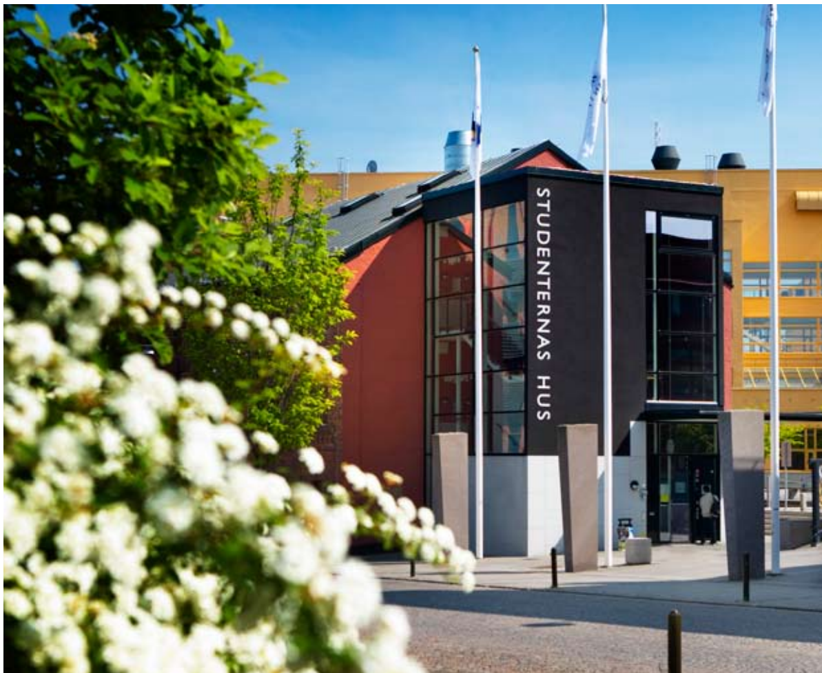
ENTRÉN och trapphuset till Studenternas Hus är en påbyggnad, där det nya moderna möter det äldre.
